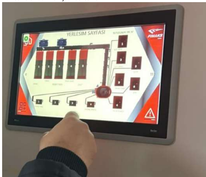
W pełni zautomatyzowana linia żywieniowa FIMAKS pozwala podawać nawet 15 składników jednocześnie
