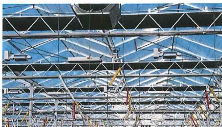
Rysunek 9. Przykład transponderów UWB zamontowanych na konstrukcji nośnej szklarni (źródło: www.pozyx.io )
