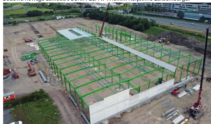
Budowa nowego zakładu JOSKIN ESA w Wielkim Księstwie Luksemburga.
